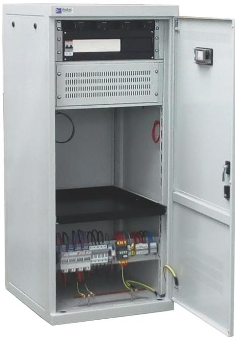
El **RAF Ilion** va asociado al controlador **Smartpack**, que ofrece una gran facilidad de monitorización y configuración del retificador, tanto en local mediante su display LCD de alta resolución, como remotamente mediante gestor web, SNMP o Modbus.
