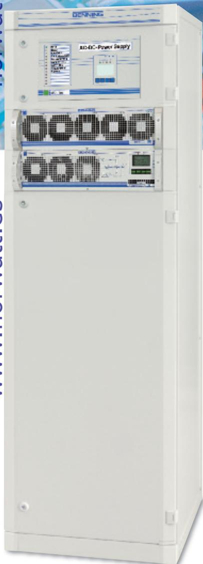
Fig. 8: Cabine onduleur-redresseur avec 3 modules onduleurs, un contacteur statique et un by-pass manuel, Puissance totale AC de 4,5kVA, 5 redresseurs modulaires de tension de sortie 220V DC avec un courant de 50A
