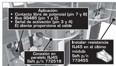
Figura 8: Conexión de la Comunicación con módulos en paralelo
